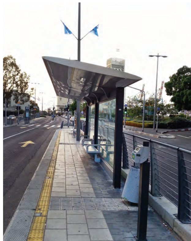
Зупинки у місті Хайфа обладнані сміттєвим баком, апаратом для продажу квитків, захищені від опадів, а мощення поряд відповідає потребам людей з порушенням зору. Ізраїль. Фото: Олександр Макаренко
